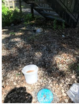
Figur 13. Renspumpning av grundvattenrö- ren utfördes vid installationstill- fället med wattera-pump.
